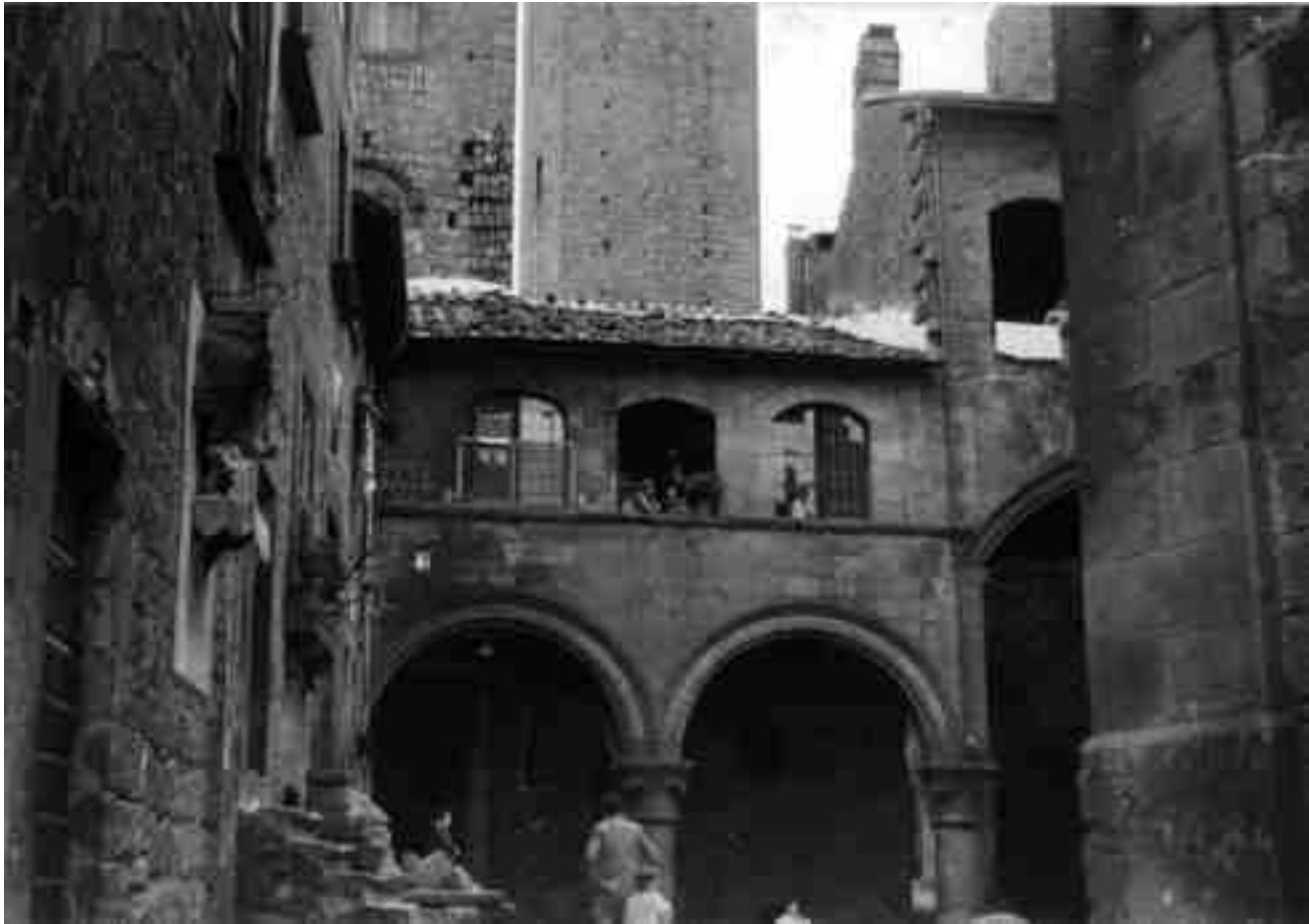
Fig. 2 Veduta di Piazza S. Pellegrino con finestre e torri degli Alessandri (1956)
